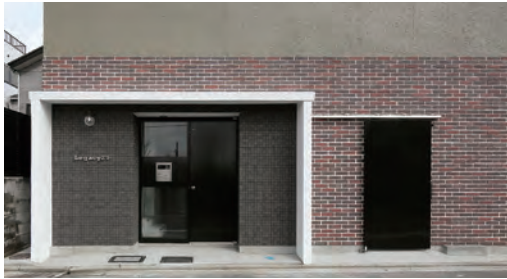
エントランス部分
